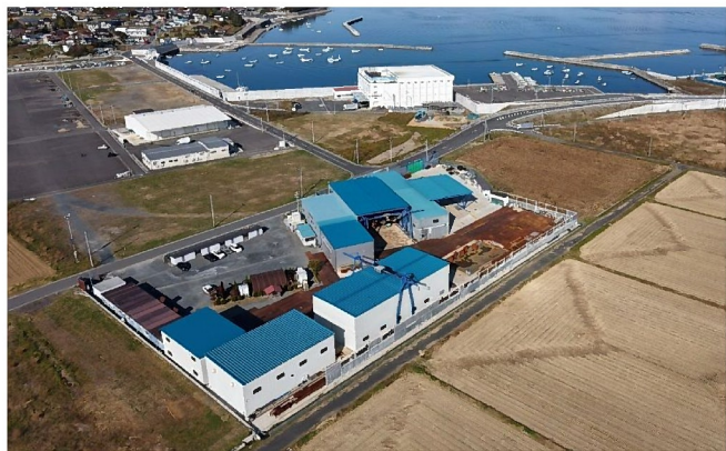
現在の工場ドローン画像
